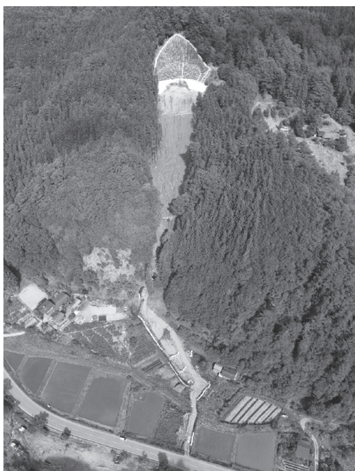
油山沢復旧治山工事・計画箇所全景(資料より)
