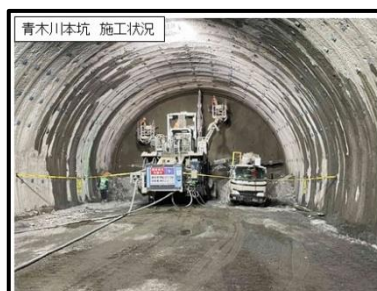
青木川本坑 施工状況
