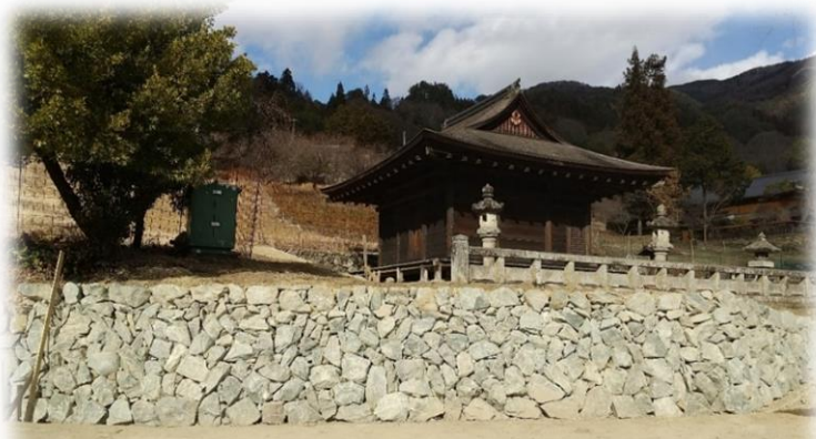
国重要文化財 福德寺石垣(講師施工)
