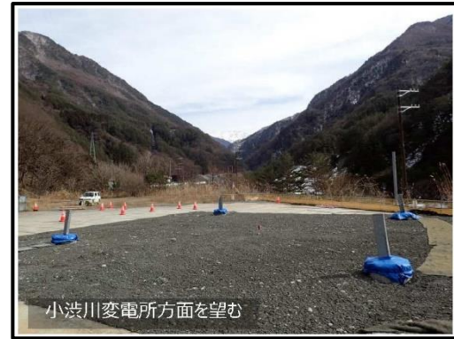
No.29 基礎工事完了
