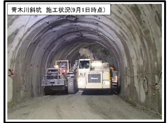
青木川斜坑 施工状況
