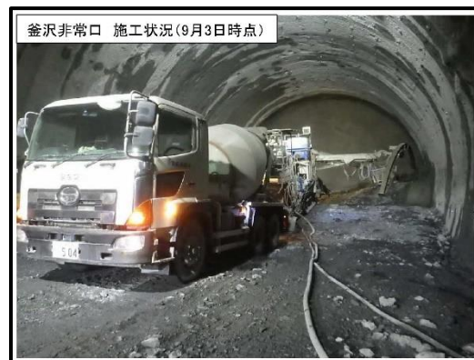
釜沢非常口 施工状況
