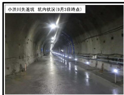
小渋川先進坑 施工状況
