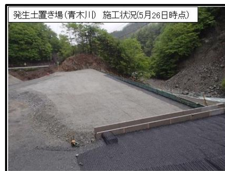
発生土置き場（青木川）施工状況
