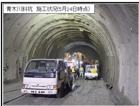
青木川斜坑 施工状況
