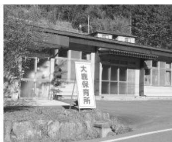
保育所仮園舎となっている授産所鹿塩分場
