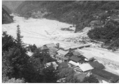
三六災・鹿塩向田被災状況
