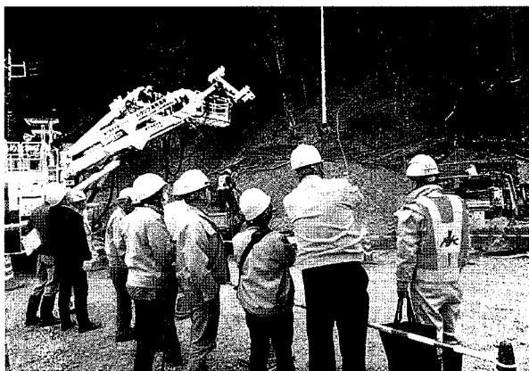
小渋川非常口・保安林解除予定地視察
