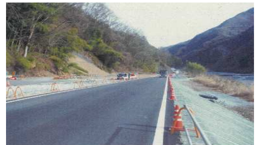
県道赤石岳公園線 改良状況
