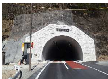
トンネル起点(松川側)
