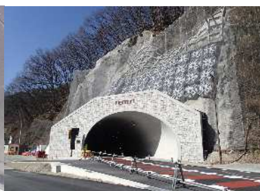
トンネル終点(大鹿側)
