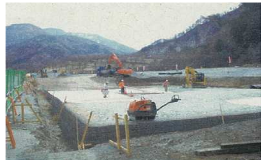
村総合グラウンド 施工状況
