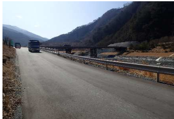
供用開始した栈橋③
