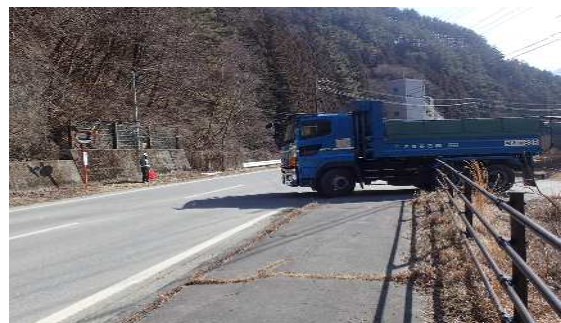
国道152号(由井神)誘導員配置状況
