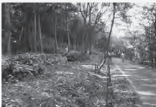
緩衝帯の整備
