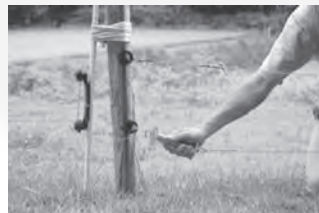
侵入防止柵の設置
