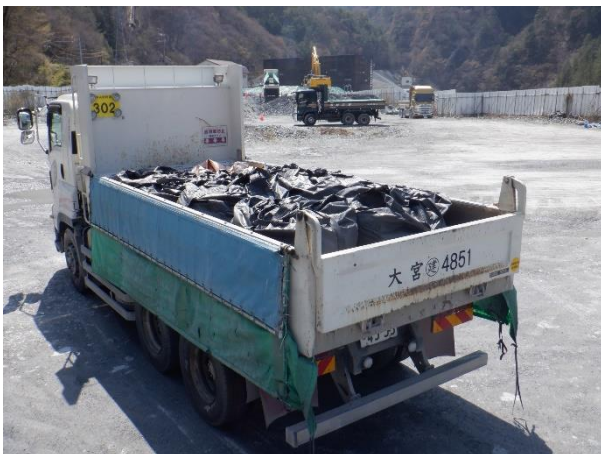
（大型土のうをダンプに積載した状況）
