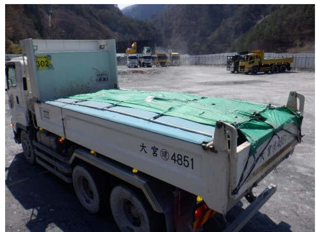
（要対策土を運搬する時の状況）
