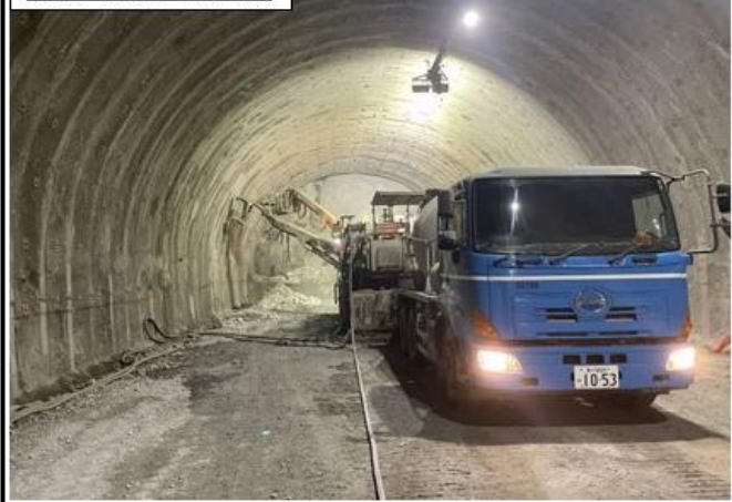
小渋川非常口（本坑） 施工状況
