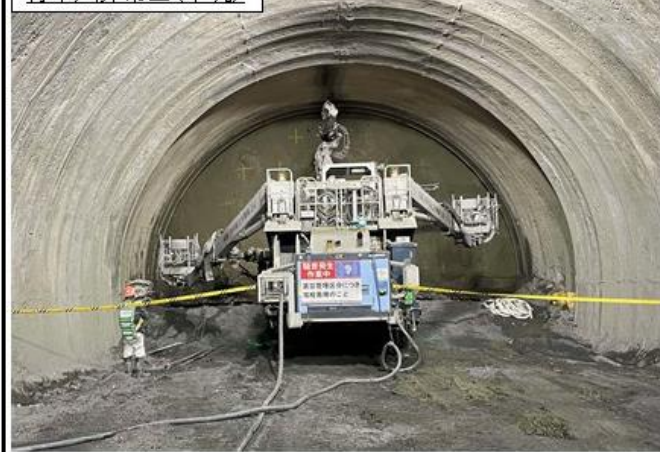
青木川非常口（本坑） 施工状況
