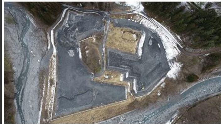
発生土仮置き場B(現在の状況) 仮置き量:締固めで約27,000m 3
