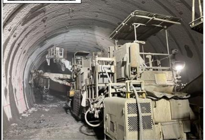
釜沢非常口（先進坑） 施工状況
