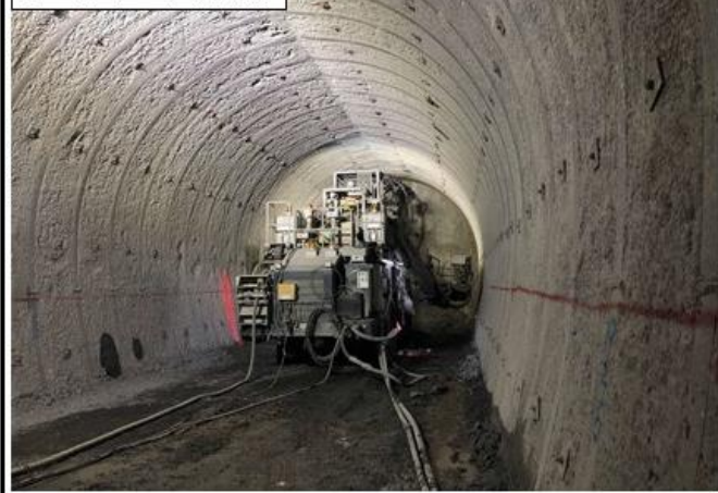
除山非常口（先進坑） 施工状況
