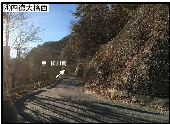
防災対策工事：地質調査・測量設計
