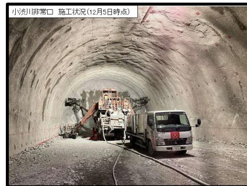
小渋川非常口 施工状況
