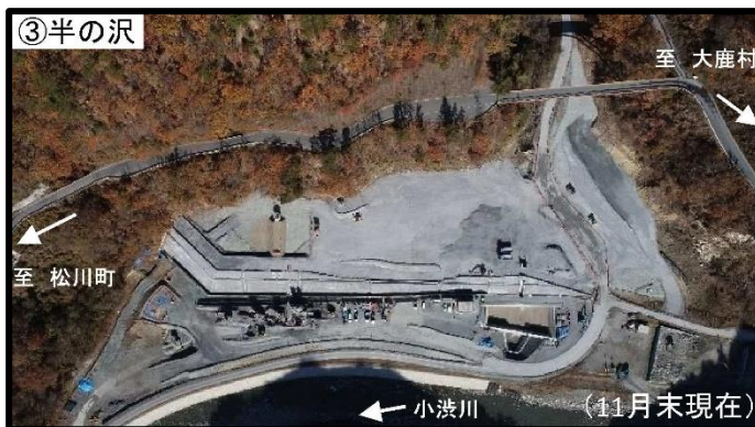
道路改良工事：盛土造成工事
