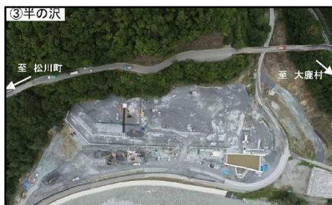
道路改良工事：盛土造成工事
