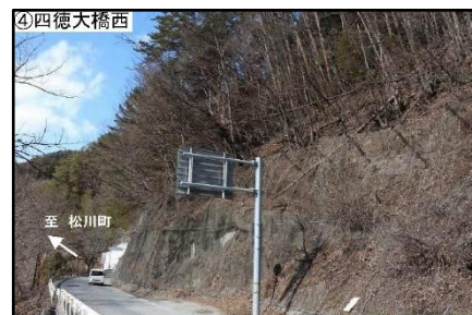
防災対策工事：地質調査・測量設計
