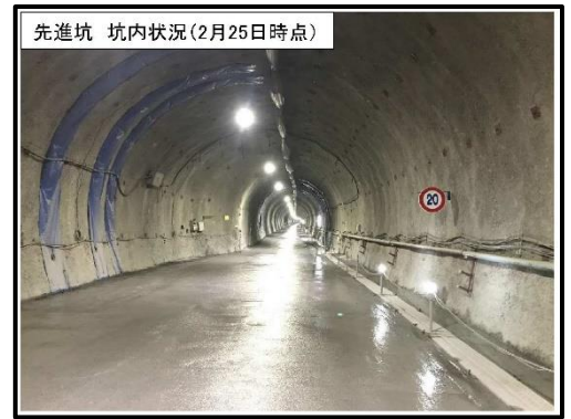
小渋川先進坑 坑内状況
