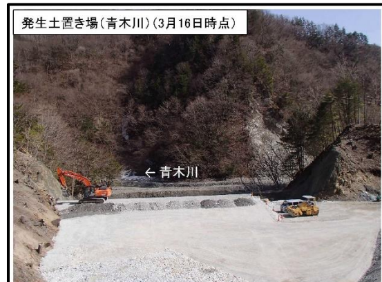
発生土置き場（青木川）
