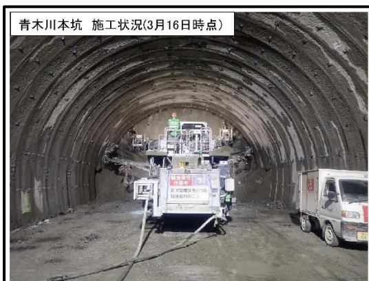
青木川本坑 施工状況
