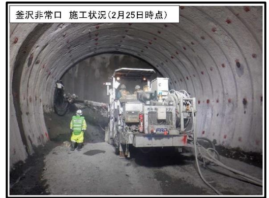
釜沢非常口 施工状況
