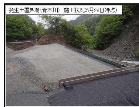
発生土置き場（青木川）施工状況
