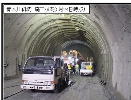
青木川斜坑 施工状況
