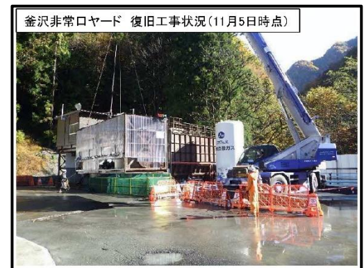
釜沢非常口ヤード 復旧工事状況
