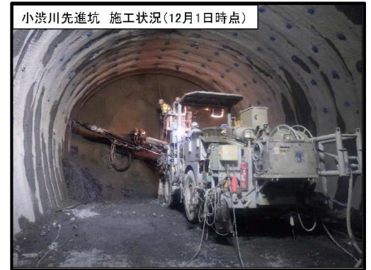
小渋川先進坑 施工状況
