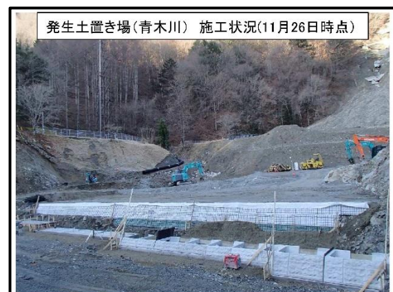
発生土置き場（青木川） 施工状況
