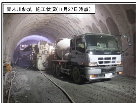
青木川斜坑 施工状況
