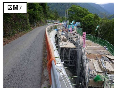
場所打ち杭工
