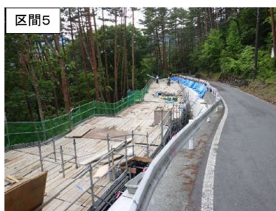
場所打ち杭工
