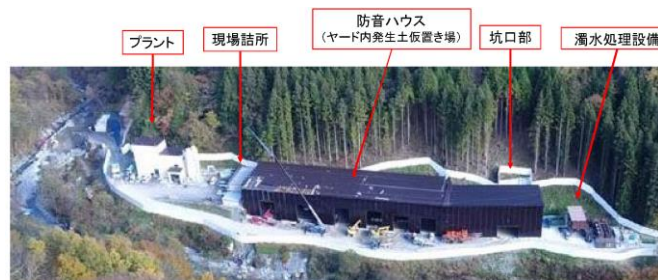
除山非常口ヤード
