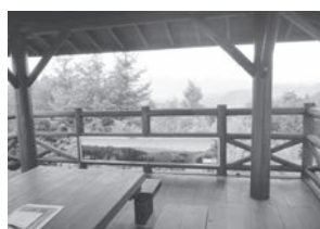
展望台より（施工前）
