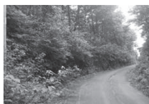
林道沿線(施工前)
