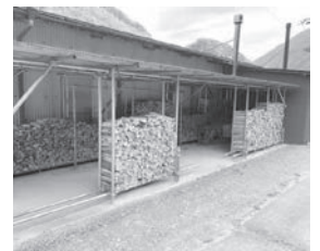
コンクリート舗装
