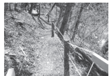
木橋・手摺補修
