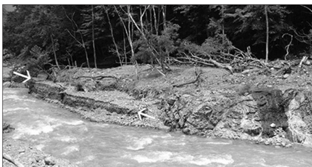
写真3 増水時にたまった土砂が残っています
