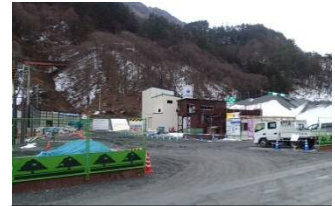
小渋川非常口ヤード整備
