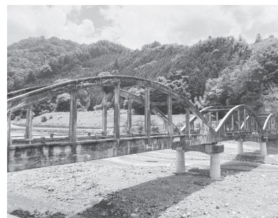
修繕工事が終わった小洪橋
