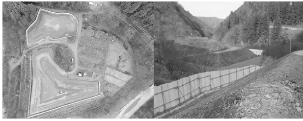
釜沢地区発生土仮置場 (J R東海リニア連絡協議会資料より)
