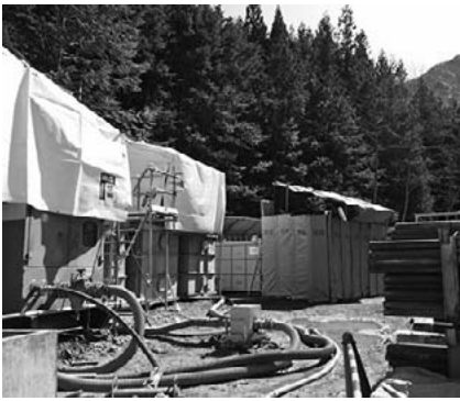
釜沢地区・水平ボーリング調査現場 発電機に防音シートがかけられている
