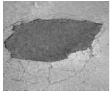
(舗装補修完成)
