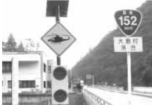
▶新落合橋脇に設置された「注意信号」。普段は点滅していません。ヘリコプターが接近すると、点滅します。
