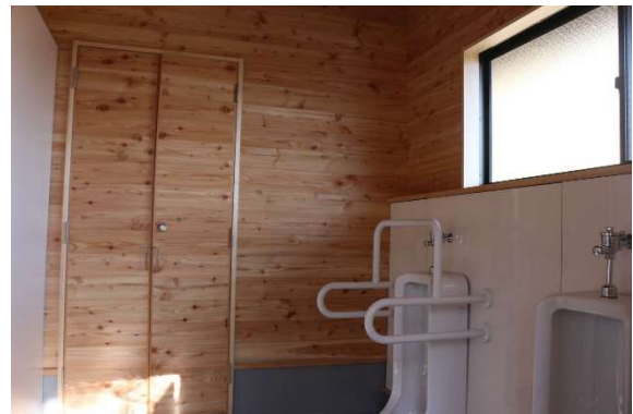
建替えた屋外トイレ
