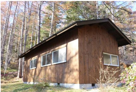
修繕した避難小屋
