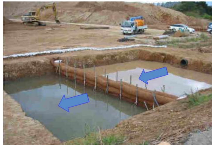
沈砂池設置例
