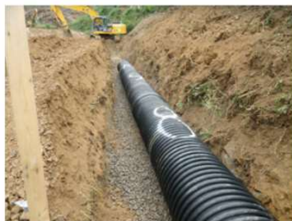
排水工(地下排水管)
